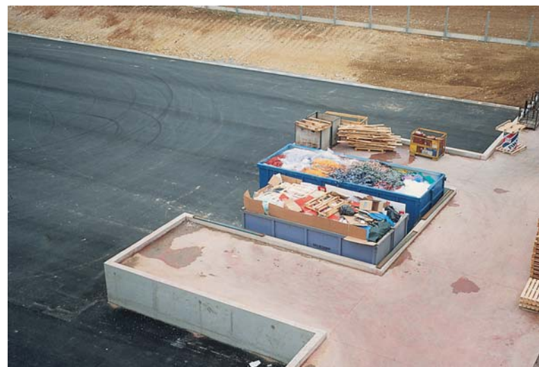
Figure 36. Implantation des bennes à déchets.
