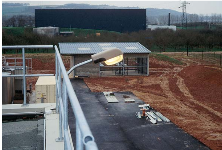
Figure 46. Luminaires extérieurs accessibles en terrasse pour l'entretien.
