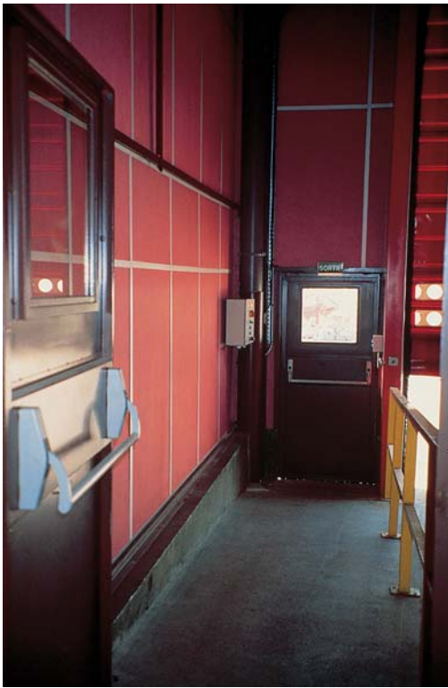
Figure 12. Garde-corps de protection entre passages piétons et engins.
