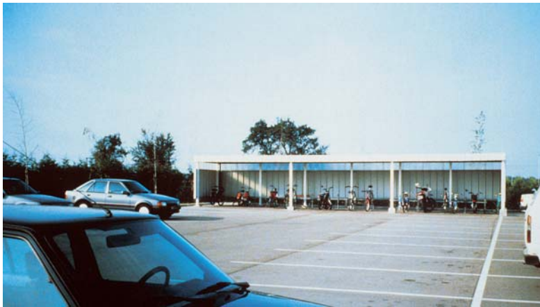
Figure 30. Parking VL et abri couvert pour les deux roues.
