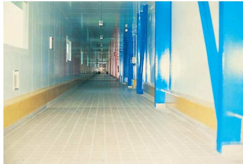
Figure 41. Couloir de circulation intérieure avec carrelage à haut coefficient de frottement.
