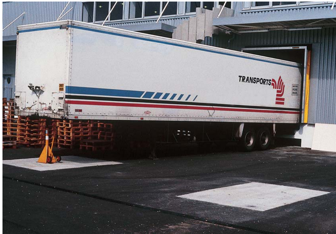
Figure 34. Aire de béquillage sur quai.
