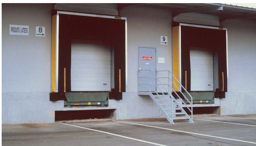
Figure 33. Aménagement d'un quai de chargement.
